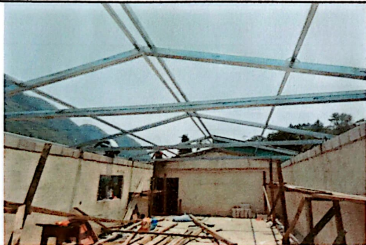
Foto 3: Se puede instalación de vigas y costaneras en un aula.
